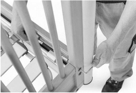
Befestigen Sie das Endstück mit den beiliegenden Schrauben (6 Schrauben pro Endstück). Diese jetzt aber nur leicht anziehen.
